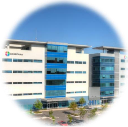
Centro de Atención Integral de Hospitalaria Monterrey, Nuevo León
